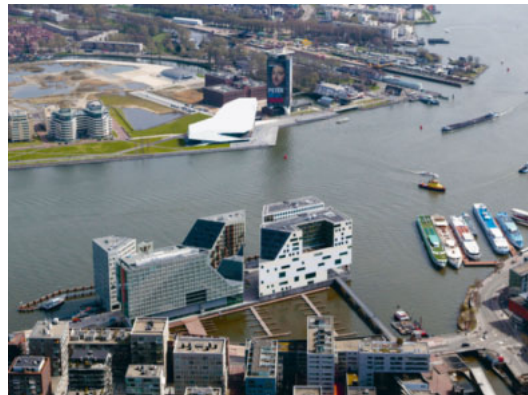
↑ «IJDock»: zentraler Baustein der Uferrevitalisierung in Amsterdam.
