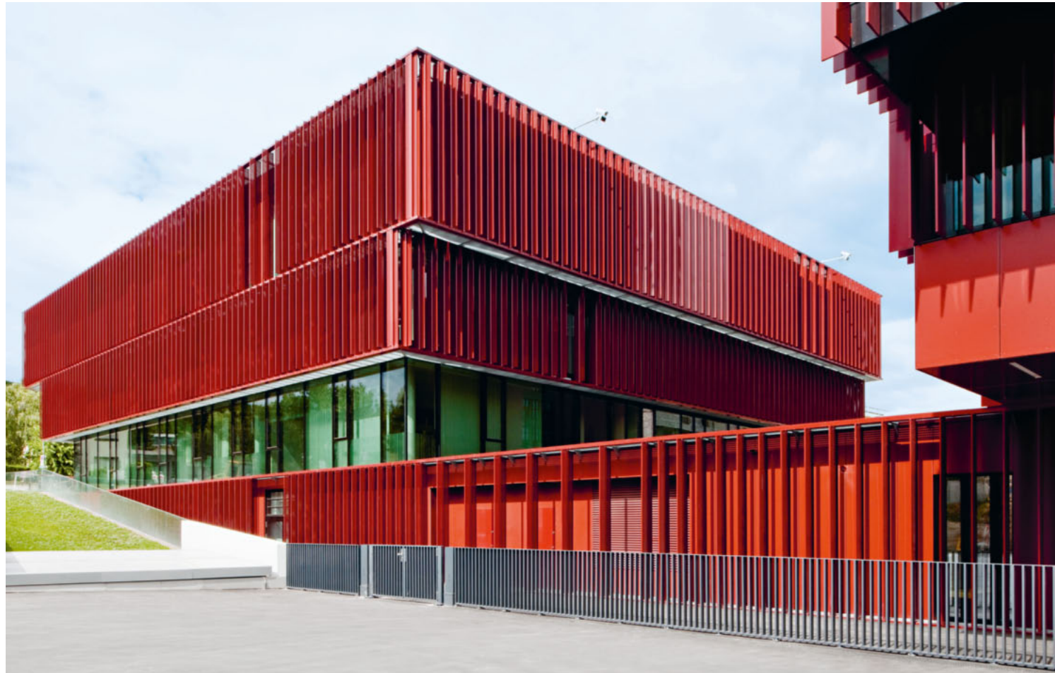
↑ Für den aus zwei Solitären bestehenden Neubau entwarfen die Architekten eine markante dunkelrote Metallhaut. Sie übernimmt gleichzeitig auch die Aufgabe als Vergitterung.
