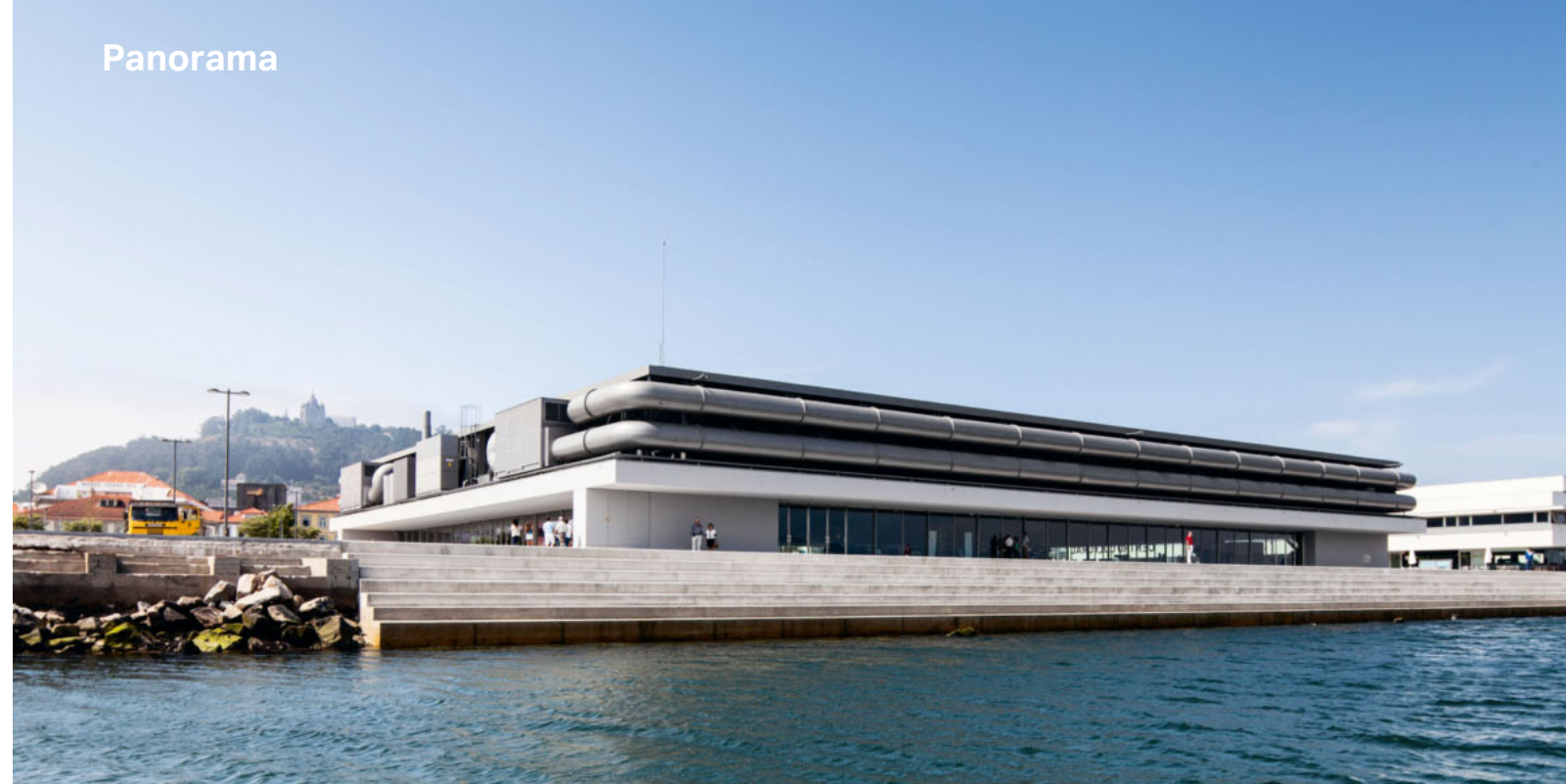
↑ Markante Pipelines und Metallaufbauten auf dem Dach, innen eine Multifunktionshalle für Sport und Kultur.
