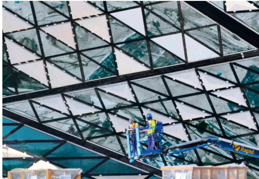
↑ Letzte Arbeiten am Konferenzzentrum.
