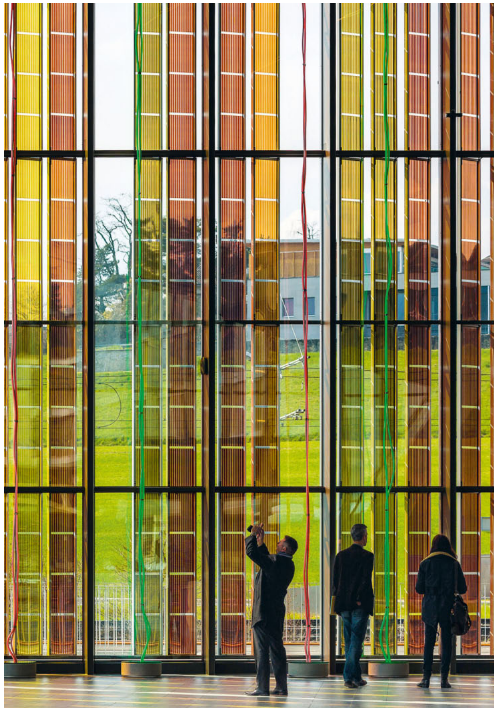
↑ Die Glasfront im neuen Kongresszentrum besteht aus bunten Photovoltaikzellen, die das Greenbuilding mit Energie versorgen.
